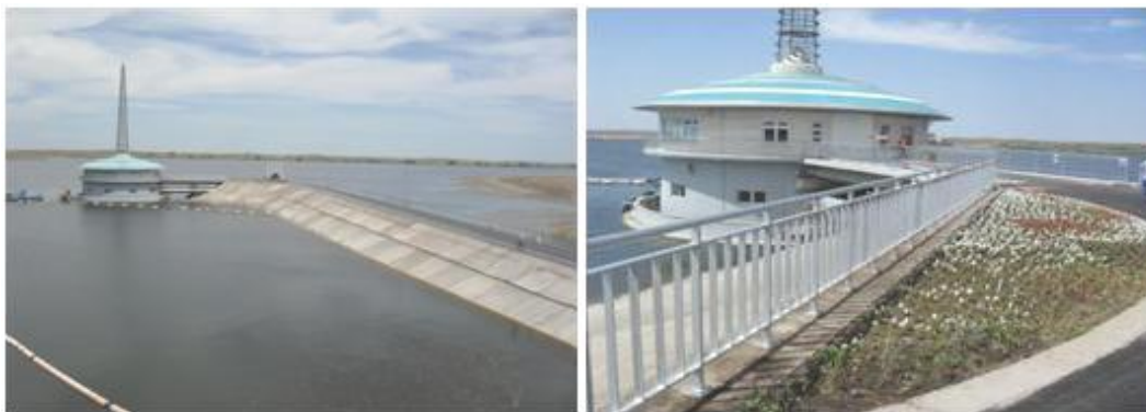
Рисунки 6-7. Общий вид водохранилища
